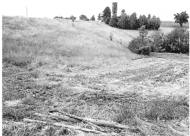
Bild 3. Das Rückhaltebecken Greuel drei Wochen nach dem Ereignis, Anfang Juni 1994. (Foto: Felix Frank)
