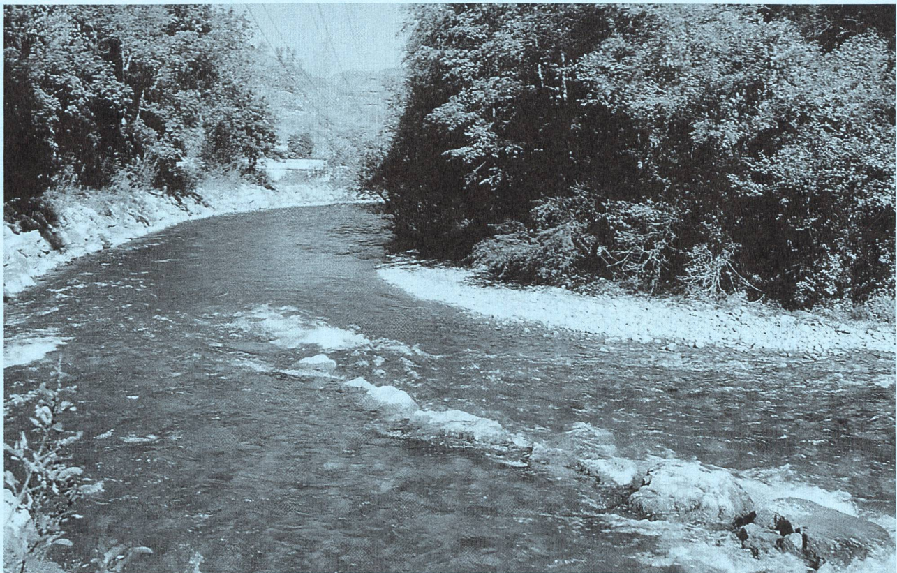
Die Kurve Ennerberg der Engelbergeraa bei kleiner Wasserführung. Das Flüsschen wird hier auf kurzer Strecke rechtwinklig umgeleitet. Dadurch ist bei Hochwasser die Kurvenaussenseite starken Belastungen ausgesetzt.
