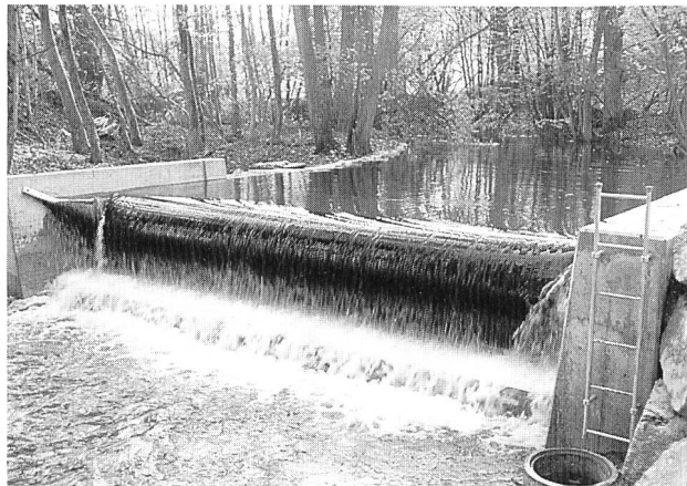
Bild 1. Luftgefülltes Schlauchwehr.
