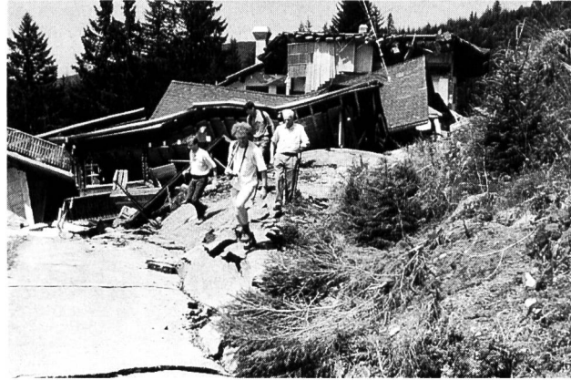
Bild 3. Auswirkungen der Rutschung «Chlöwena», Gemeinde Plasselb im freiburgischen Sensebezirk. Das massiv gebaute Hotel Falli-Höllli wurde von den Rutschungsbewegungen destabilisiert und zerstört und die Zufahrtsstrasse bis zu drei Metern angehoben. Die Aufnahme zeigt die Situation am 26. Juli 1994.
