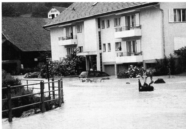
Bild 5. 19. Mai 1994: Durch die Reppisch verursachte Überschwemmungen in Birmensdorf ZH, ein typisches Bild für überbaute Gebiete nahe an Gewässern. Foto: D. Gächter, WSL
