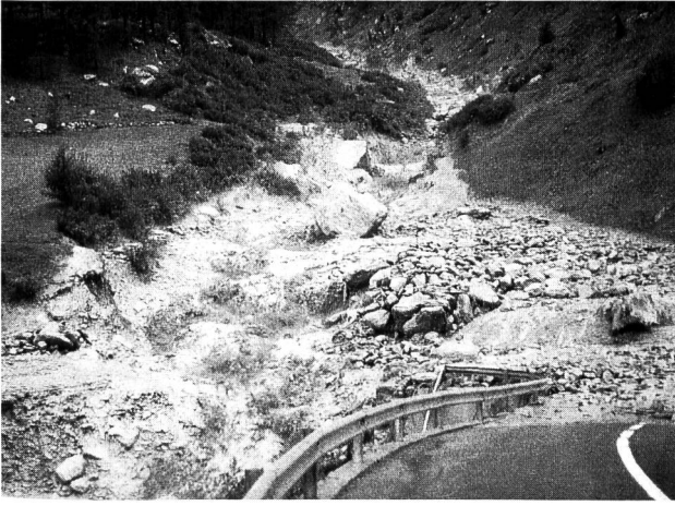
Bild 6. Murgang im Lowigraben, Simplon-Dorf VS, anlässlich der Unwetter vom 24. September 1994. Mit den Murschüben wurden auch grosse Felsblöcke abtransportiert; die Brücke wurde dabei zerstört. Foto: J. Escher, Gemeindeganzlist, Simplon-Dorf
