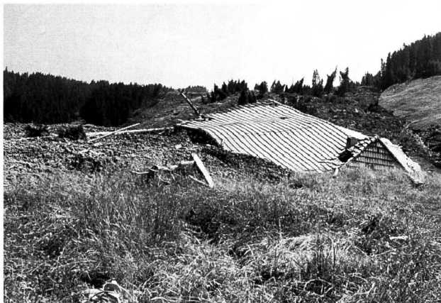
Bild 4. Rutschung «Chlöwena», 26. Juli 1994. Auf dem Foto sehen wir ein zerstörtes Bauernhaus. Einzig das Dach «schwimmt» noch auf den sich bis zu vier Metern pro Tag talwärts bewegendem Erdmassen. Foto: W. Gerber, WSL
