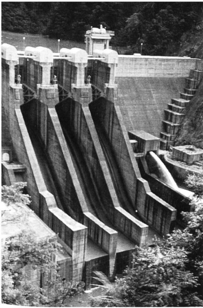
Figure 2. Vue vers l'amont du barrage de Dashidaira. Les évacuateurs de crues, les deux pertuis de purge et l'ouvrage de restitution du débit de dotation sont visibles (Photo F. Raemy).
