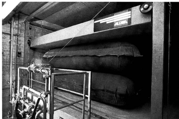
Bild 2. Der Kissengasspeicher puffert die erzeugte Biogasmenge (1994 rund 548 m 3 pro Tag).
