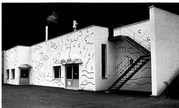
Bild 1. Hinter der unscheinbaren – vom Willisauer Künstler Niklaus Troxler gestalteten – Fassade verbirgt sich eine moderne Anlage zum anaeroben Abbau von kohlenstoffhaltigen Verbindungen im Brennereiabwasser der Diwisa.
