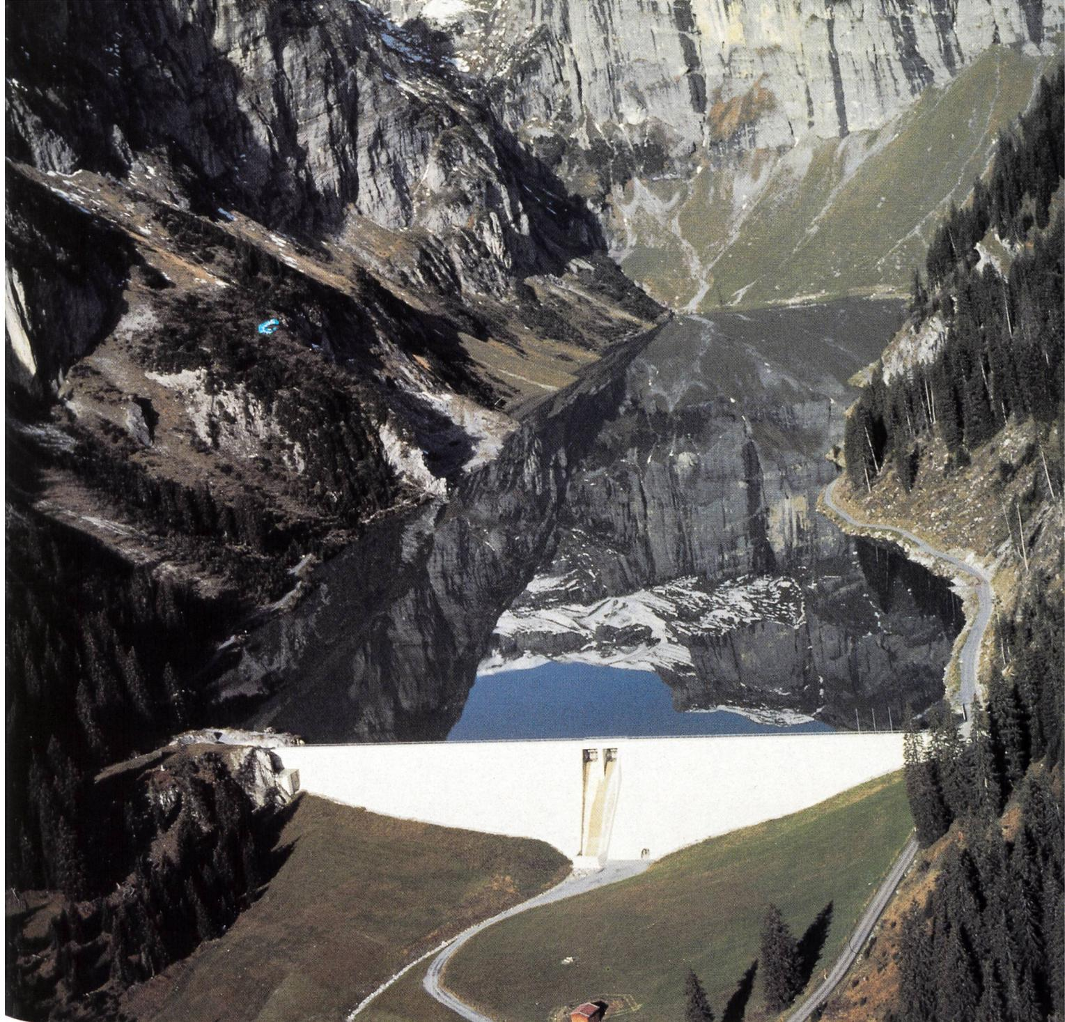
Die Staumauer Panix der Kraftwerke Illanz AG staut bis 7,3 Mio m<sup>3</sup> Nutzinhalt. Sie ist 53 m hoch; ihre Krone ist 240 m lang, und die Betonkubatur beträgt 160 000 m<sup>3</sup> (siehe auch die Beiträge S. 233–253).
