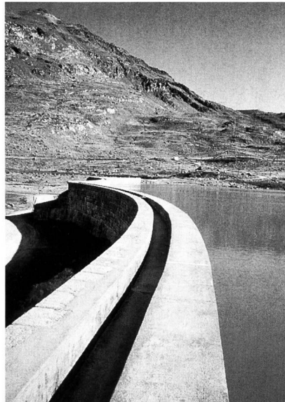
Bild 3. Die Bernina-Nordmauer bildet den Seeabschluss gegen das Engadin. Die Gewichtsmauer besteht aus drei aneinandergereihten Bogen.
