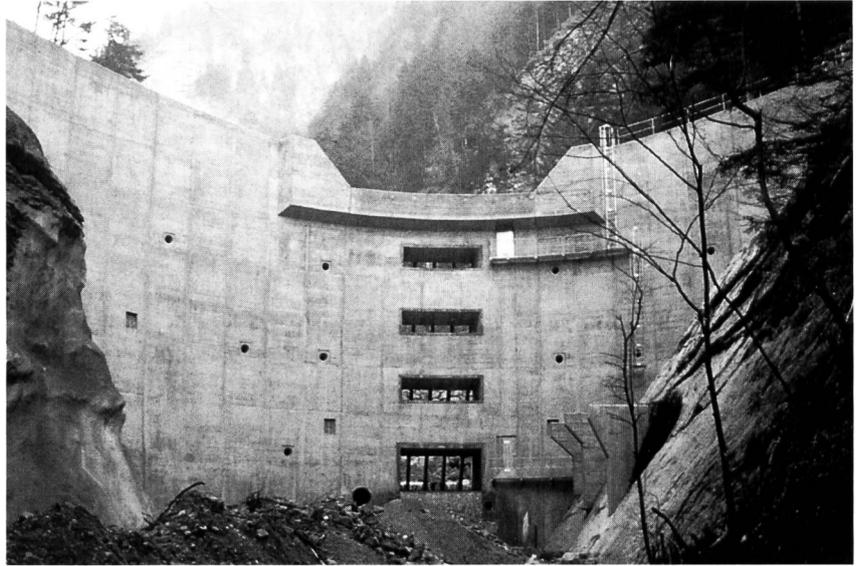
Bild 4. Geschieberückhaltesperre Palanggenbach. Ansicht von der Talseite. Am linken Bildrand ist die stabilisierte Felsflanke.
