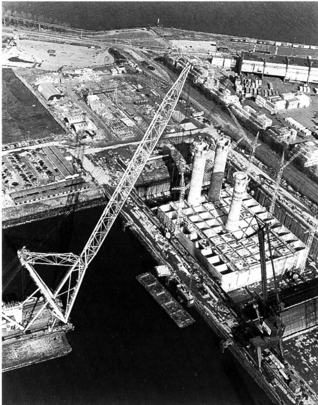
Bild 2. Betonplattform von Bild 1 in einem Dock in Rosenberg in den Niederlanden betoniert; Einbau von vorgefertigten Stahlbetonplatten als Deckel für Speicher- und Ballastzellen mit Hilfe eines grossen Schwimmkranes Taklift 7.
