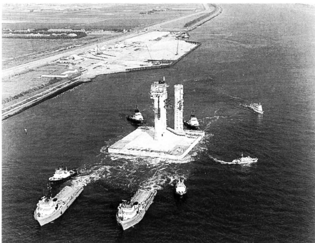
Bild 3. Die Betonplattform von Bild 2 wird in das 220 km entfernte Feld F3 der Nordsee zur Öl- und Gasgewinnung geschleppt.
