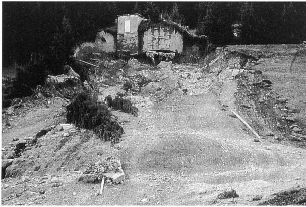
Bild 3. Davos GR, Samstag, 15. Juli 1995. Die Foto zeigt das nach dem Unwetter geborstene und zerstörte Wasserreservoir. Ursache war ein während des Gewitterregens zerrissenes Steuerkabel, woraufhin die Schieber ausser Kontrolle gerieten und das Reservoir überfüllten.
