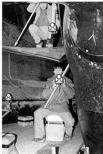
Bild 2. Vermessung der Laufschaufelkontur.
