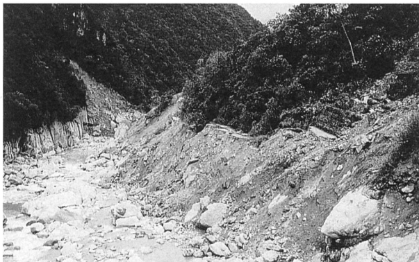
Bild 16. Abgerutschte Zufahrtsstrasse am Gegenhang des Maschinenhauses Mollino. Der ganze Hang ist destabilisiert.
