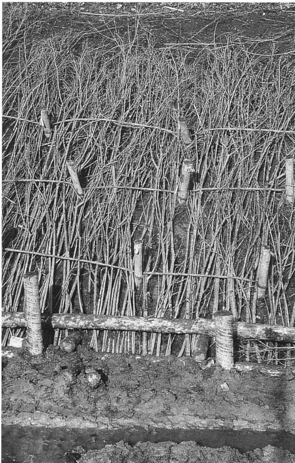
Bild 10. Ingenieurbio-logische Ufersicherung mit einer Spreitlage vor dem Abdecken mit Erde. Der Böschungsfuss wird mit einem einfachen Holzkasten gesichert, der teilweise eingegraben ist. (Als-bach Wien, März 1995/ Bild: VAW, M. Oplatka)
