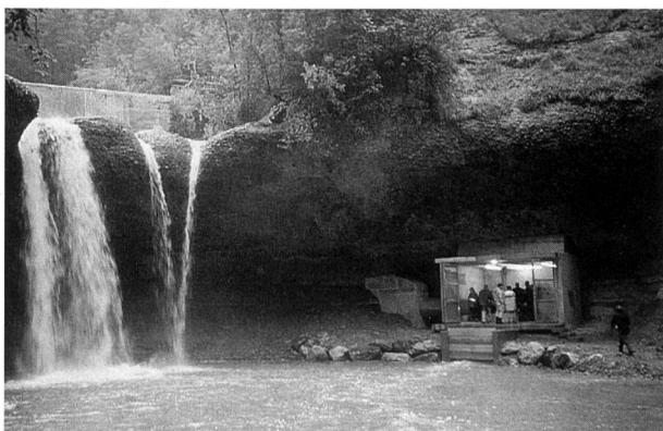
Bild 2. Die hundertjährige Staumauer wurde den neuen Sicherheitsanforderungen entsprechend sanft saniert, die früher offen geführte Druckleitung in den Fels verlegt und das Maschinenhaus gut geschützt unter eine Felsnase plaziert. (Foto Iteco, Juni 1996)
