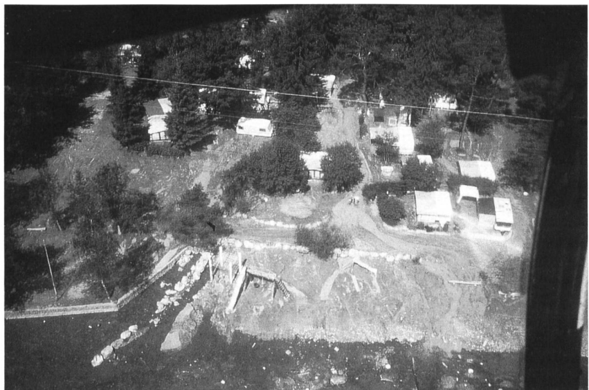
Bild 2. Das Unwetter in Giswil OW vom 9. Juni 1996. Infolge Unterspülung durch das Steinibach-Hochwasser wurde der Flügel einer massiven Betonsperre freigelegt.
