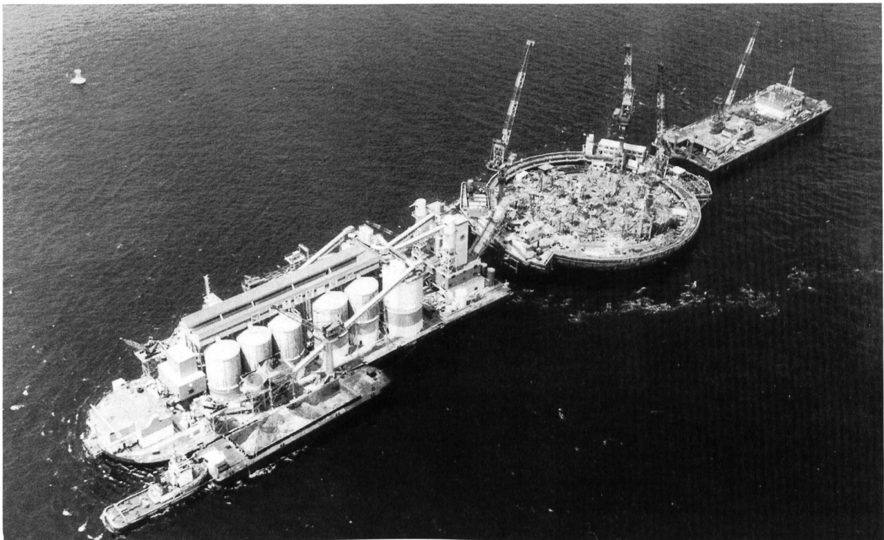
Bild 4. Caisson mit Arbeitsplattform (Betonpumpe, Roboterüberwachungseinrichtungen) und schwimmende Betonfabrik (links).
