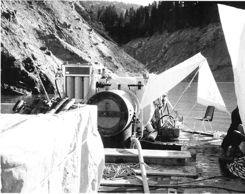
Bild 7. Arbeitsponton mit Dekompressionsanlage.
