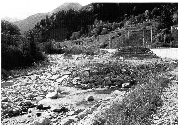
Bild 5. Halbinsel kurz nach Beendigung der Bauarbeiten, im Hintergrund künstlicher Umlenksporn (Gurtellen-Wiler).
