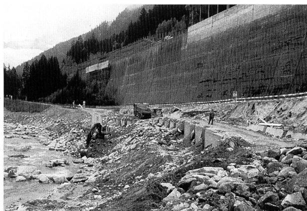
Bild 22. Betonprismen während der Überschüttung (Gurtellen-Güetli).
