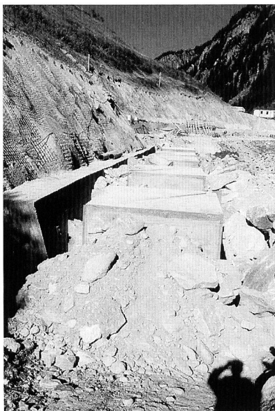
Bild 16. Im Wuhrweg eingegrabene Betonwürfel (Göschenen-Stäfeligand).
