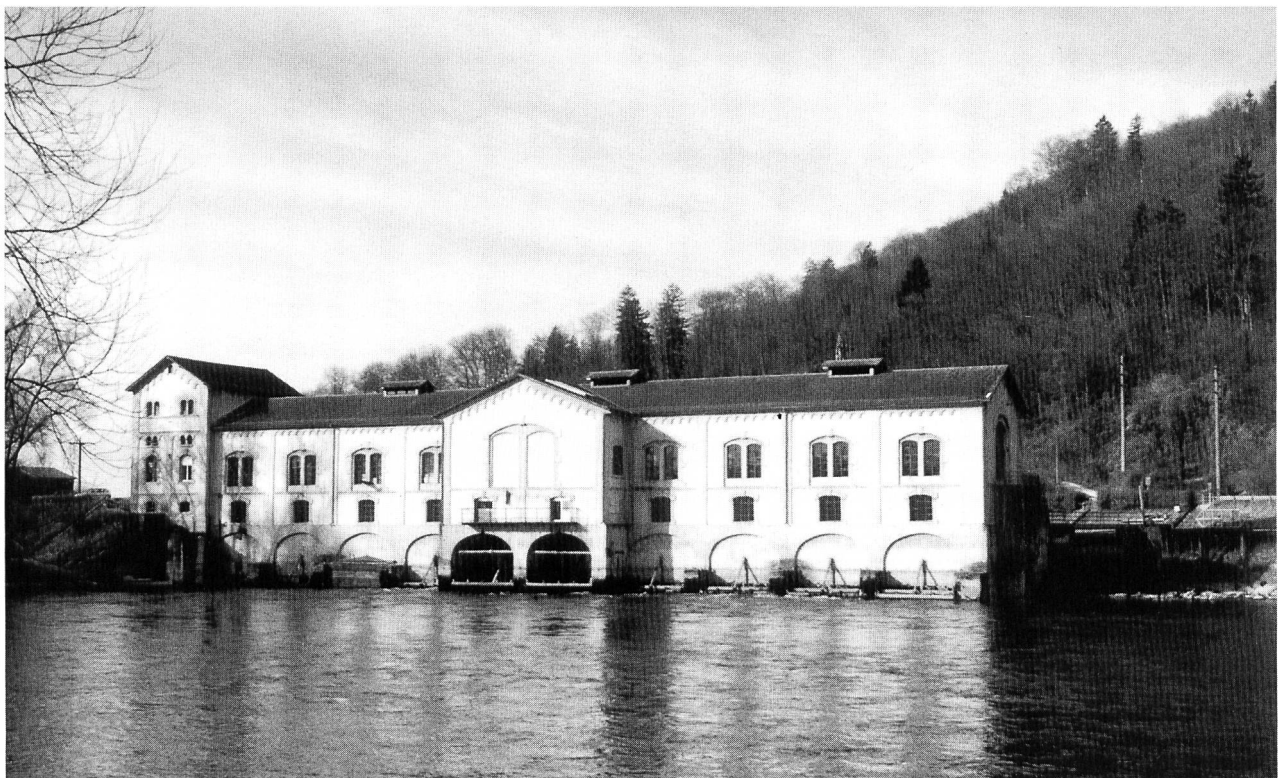
Bild 1. Das Aarekraftwerk Ruppoldingen.
