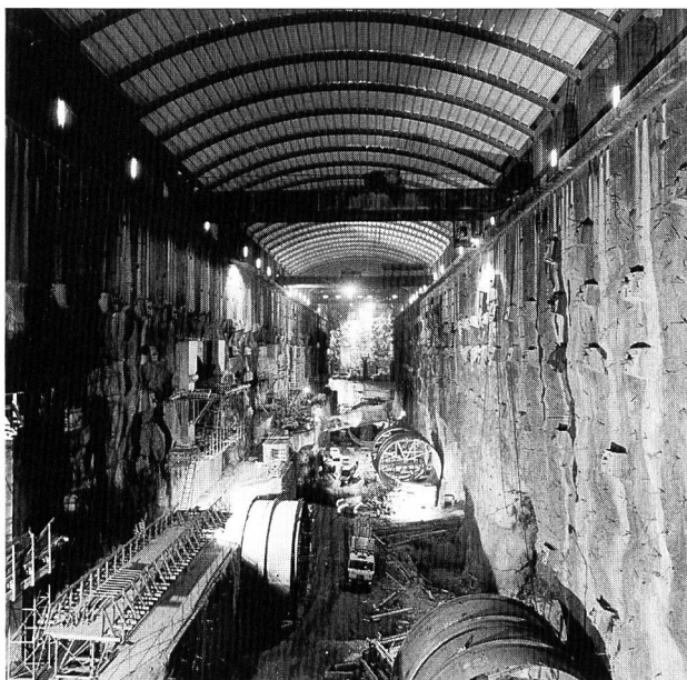
Bild 3. Blick in die Kraftwerkskaverne.
