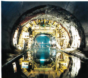
Legende zu Titelblatt: Betonchalung im Unterwasserstollen Amsteg (Foto P. Mainardi vom 26. September 1995).
