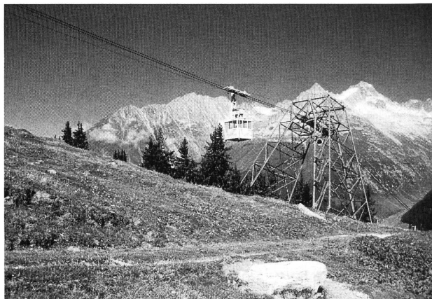
Die Werkseilbahn Sedrun–Tgom der Kraftwerke Vorderrhein steht seit Mitte Juli auch Touristen zur Verfügung. Gegen einen Kostenbeitrag befördert die Bahn pro Fahrt jeweils acht Passagiere zur Bergstation Alp Tgom.
