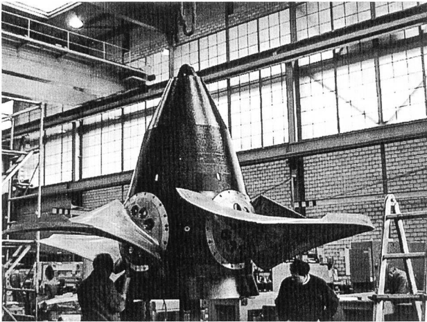
Bild 1. Mit dem neuen Laufwerk kann die Leistung des Wasserkraftwerks Bannwil erhöht werden.
