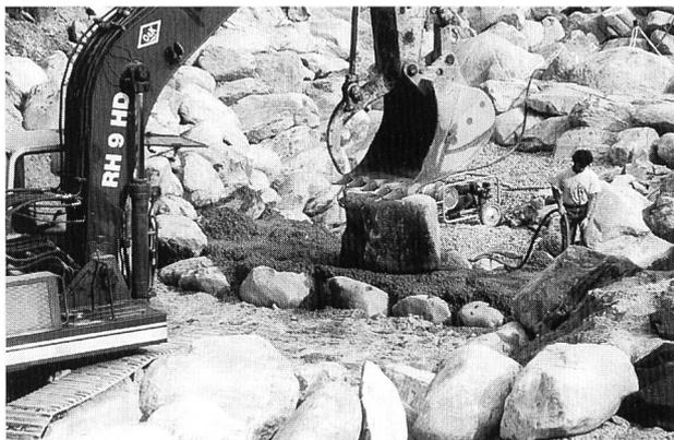
Bild 4 (August 1995). Gerinnesicherungsarbeiten im Schützbereich, hier am Fusse der Steilstrecke. Das verwendete Schüttmaterial bestand aus gefrästem Vereina-Tunnelausbruch und wies ein Maximalkorn von lediglich etwa 15 mm auf.
