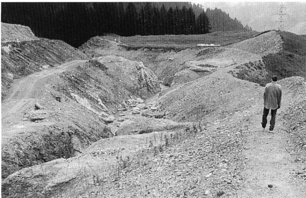
Bild 3 (Mai 1998). Das neugestaltete Stützbachgerinne windet sich heute in einem 10 bis 20 m tiefen Einschnitt durch das Selfranga-Plateau. Links die noch zu «kaschierende» Baupiste, rechts der neu angelegte «Schluchtweg» als beliebte Wanderwegverbindung zwischen Davos und Klosters.
