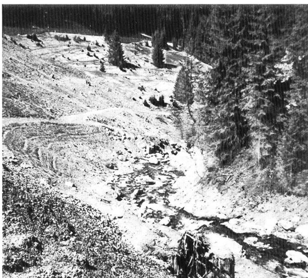
Bild 5 (Mai 1997). Blick in den grosszügig angelegten Mittellauf im geschütteten Gerinneabschnitt. Links die der natürlichen Begrünung überlassene Schütthöschung «Bim Bad».
