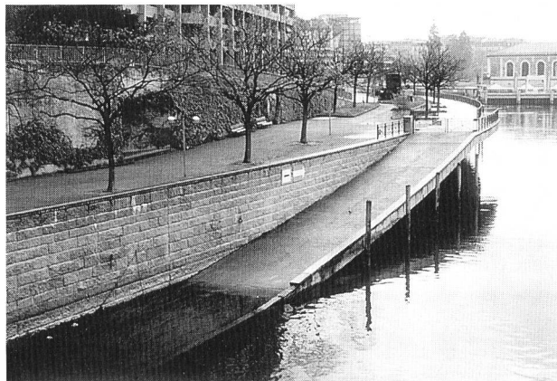
Figure 7. La pratique de la navigation touristique sur des retenues nécessite des rampes de mise à l'eau permettant d'accéder facilement avec la remorque porte-bateau et son véhicule tracteur. La rampe du quai du Seujet (notre vue) répond à cette exigence.
