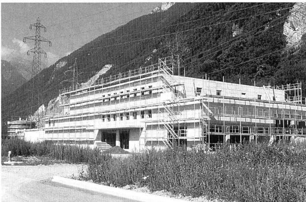
Figure 1. Vue d'ensemble de la future extension de la STEP de Roche VD, angle sud-est.
