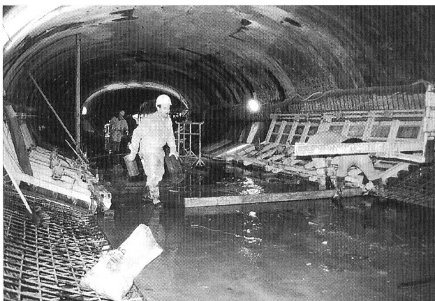
Bild 2. Betonieren der UW-seitigen Stollensohle mit Konterschaltung.
