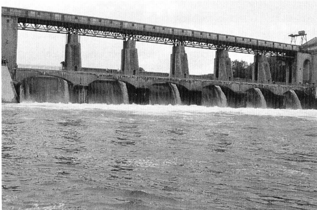
Bild 1. Stauwehr des Flusskraftwerks Eglisau mit einer maximalen Stauhöhe von 10,8 m.
