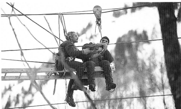
Bild 1. Aufräum- und Reparaturarbeiten im Schadengebiet der Fur-bachlawine zwischen dem Kraftwerk Tierfehd und Linthal.
