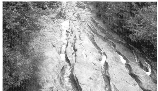
Figure 5. Spectaculaire seuil de molasse en état d'érosion par les galets charriés (Alte Schwarzwasserbrücke).
