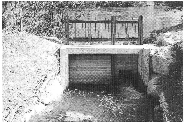
Bild 5. Einlauf der Limmat in das Umgehungsgewässer mit der neuartigen Tafelschütze für die Wasserregulierung (Foto J. Loos, Wettingen).
