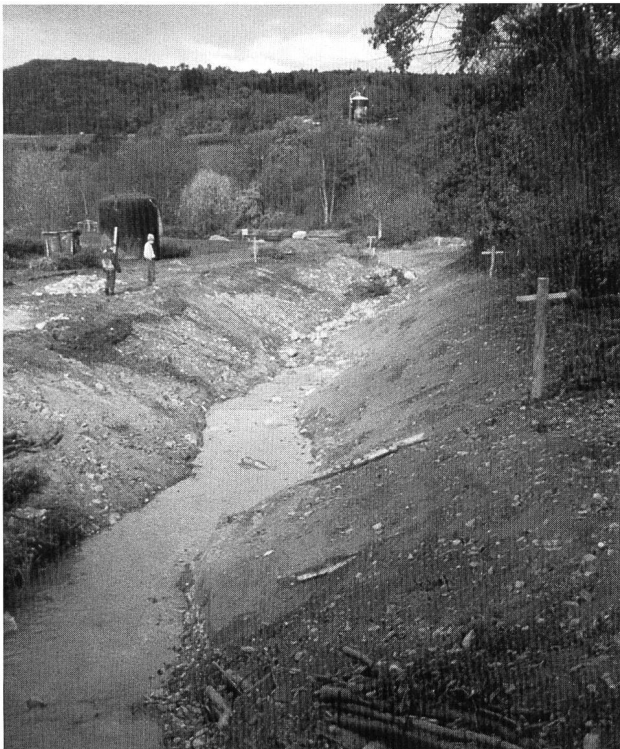
Bild 1. September 1997: Die Arbeiten am neuen Umgehungsgewässer sind beendet, das Gerinne wird in Betrieb genommen (Foto J. Loos, Wettingen).
