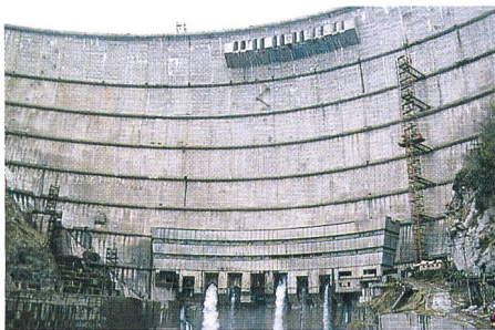
Bild 3. Luftseitige Ansicht der Mauer mit Kontroll-Laufstegen.
