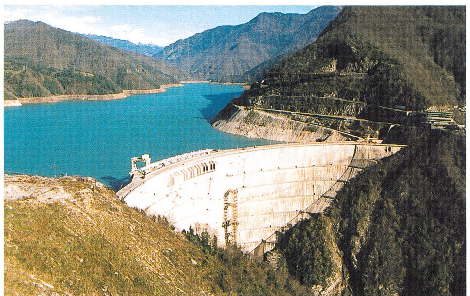
Bild 1. Übersicht über die Staumauer Enguri.
