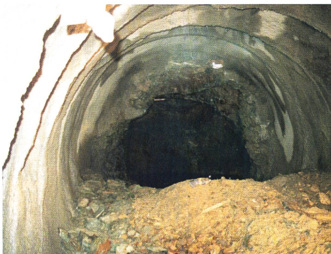
Bild 3, links. Händischer Vortrieb vor dem Fräskopf im unteren Druckstollen in der Triaszone. Sicherung mit Stahleinbau und Spritzbeton. Bild 4, rechts. Fräsvortrieb im unteren Druckstollen nach dem Einbruch. Die Fräse ist grösstenteils wieder freigelegt. Im linken Parament sind Rauhackebänke sichtbar, die ein Verspannen der Gripper massiv erschwerten.
