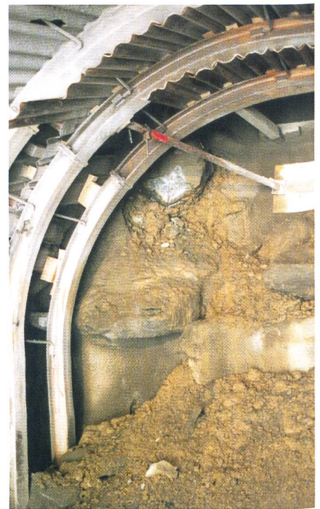
Bild 2. Marciavanti-Vortrieb im Rohrstollen durch die Sackungsmasse.
