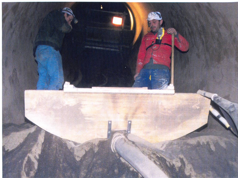
Bild 12. Korrosionsschutz im Schrägschacht. Arbeitsbühne und Strahlsand, der in Handarbeit nach unten befördert werden musste.
