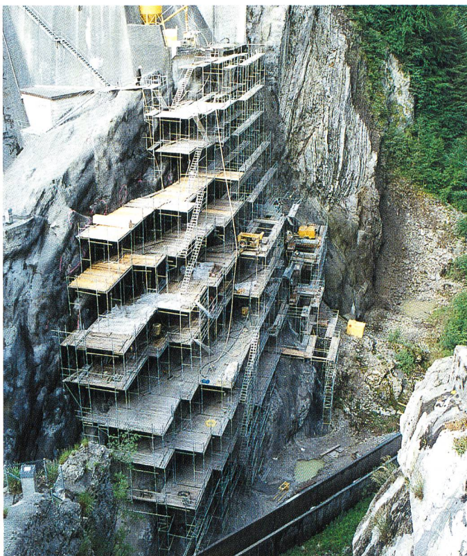
Figure 11. Appui rive gauche du barrage de Montsalvens: montage de l'échafaudage et travaux de nettoyage de la falaise.
