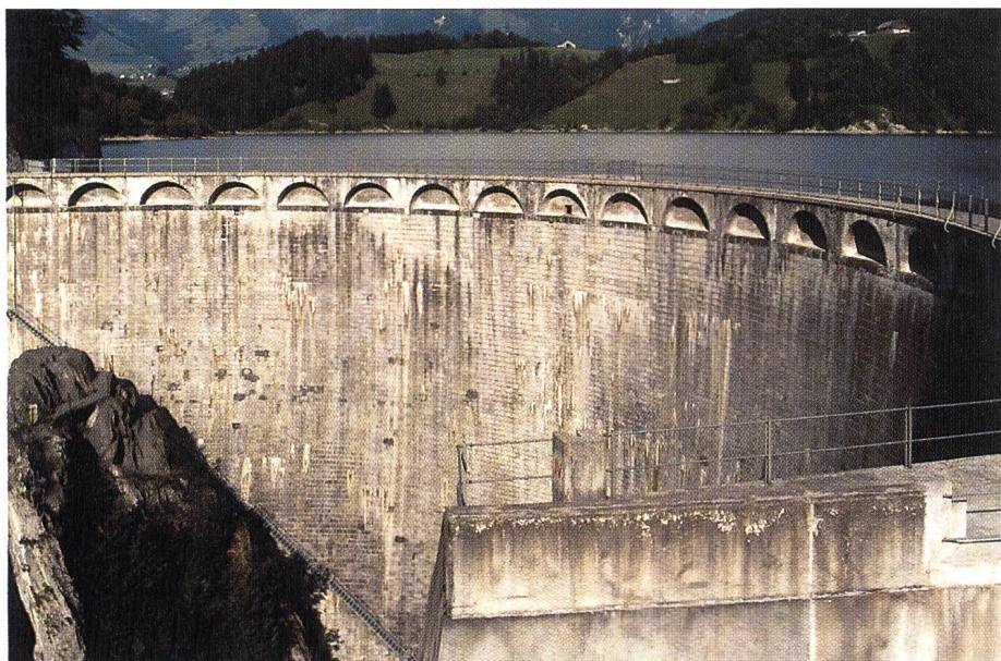
Figure 3. Vue aval du barrage de Montsalvens avant les travaux de réhabilitation.
