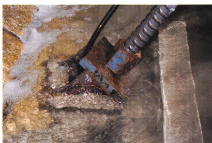
Bild 7. Pfahlschuh (unter Wasser versetzt) nach Entleerung.
