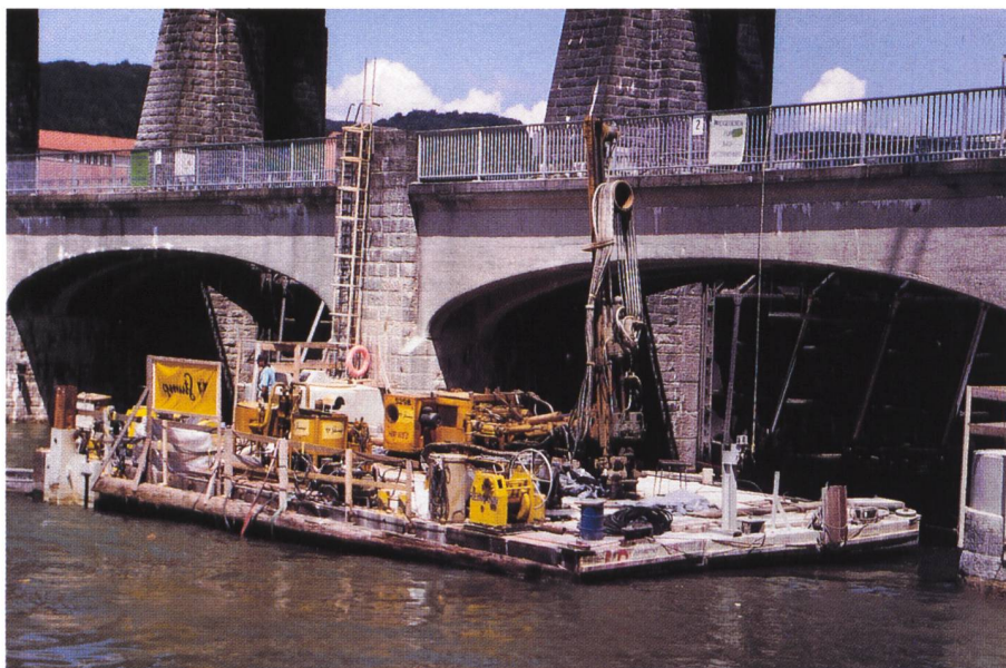
Bild 5. Floss für Bohrarbeiten und Installation von Mikropfählen.
