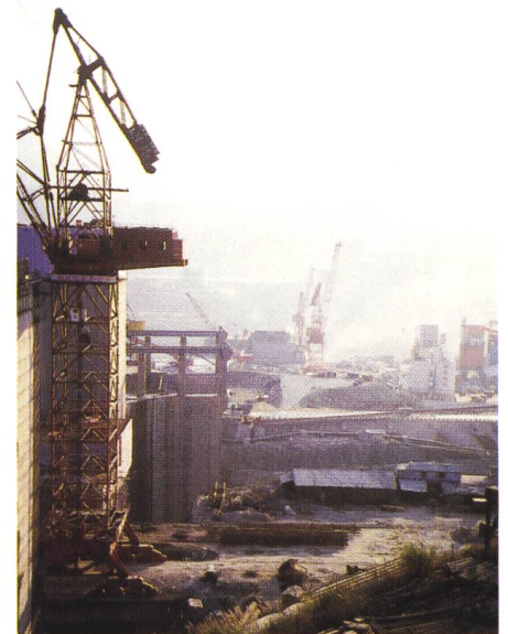
Bild 5. Schiffshebewerk im Bau und Betonmischanlage (rechts).
