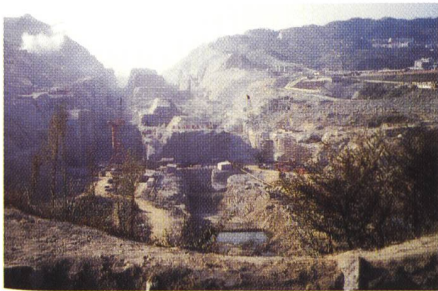
Bild 4. Gebirgsabtrag für den Bau der Schleusenanlage.
