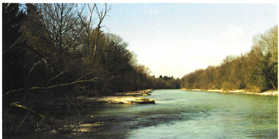
Bild 11. Buhnen an der Aare, aufgebaut aus Kies und Blöcken mit Oberflächenschutz aus Beton (Blick in Fließrichtung).
