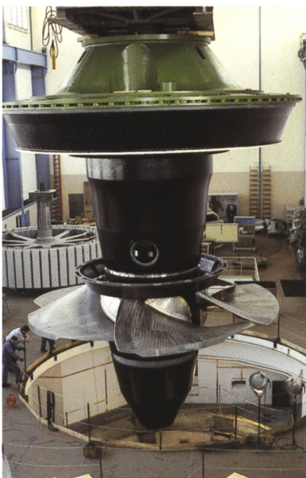
Bild 11. Kraftwerk Wildegg-Brugg, MG1: Einbau des neuen Turbinenlaufrades mit erhöhter Leistung.
