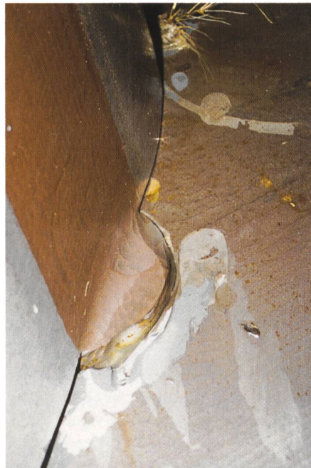
Bild 9. Kraftwerk Wildegg-Brugg: Turbine 2: Verschleiss am unteren Leitradring und an den Leitschaufeln.
