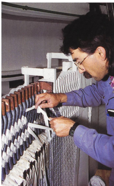
Bild 13. Kraftwerk Wildegg-Brugg, MG1: Statorwicklung des Generators 1 mit neuen Blechpaketen.
