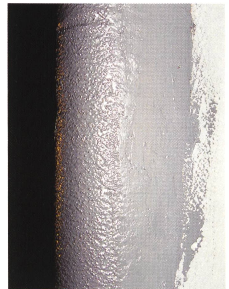
Bild 6. Kraftwerk Wildegg-Brugg: Stützschaukel nach der Revision.
