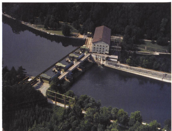
Bild 3. Kraftwerk Rapperswil-Auenstein: Stauwehr und Maschinenhaus.
