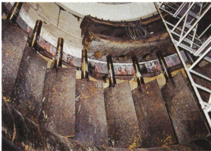
Bild 7. Kraftwerk Wildegg-Brugg: Turbine 1: Demontage der alten Leitschaufeln.
