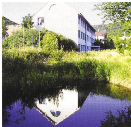
Bild 2. Regenwasserentsorgung beim Schulhaus Hohmatt: Das Regenwasser fliesst in ein naturnahes Rückhaltebecken und danach in einen Teich.
