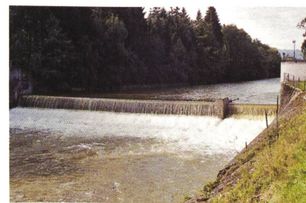
Bild 9. Wehr Schachenheim flussaufwärts mit Gegengewichts-Stauklappe links und Spülklappe rechts. Über die kleinere Spülklappe erfolgt bei geringer Wasserführung die Restwasserdotierung.
