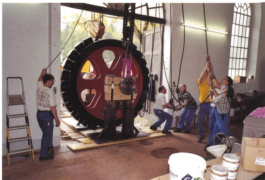
Bild 7. Das 11 Tonnen schwere Generatorpolrad wird nach der Neuisolierung und Revision wieder ins Zentralengebäude eingebracht.
