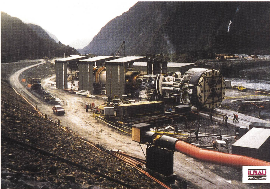
Bild 1. Offene Hartgesteins-Tunnelbohrmaschine mit 10 m Bohrkopfdurchmesser und Nachläufer.
