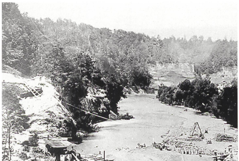
Fig. 1. Vue du barrage de la Maigrage durant sa construction en 1870.
