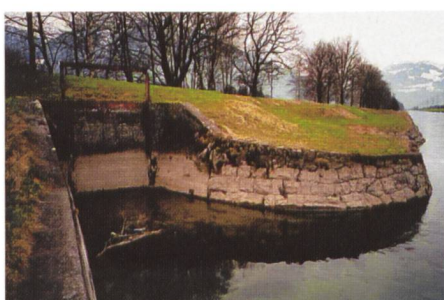
Bild 3. Durchlass Au mit Linth.
