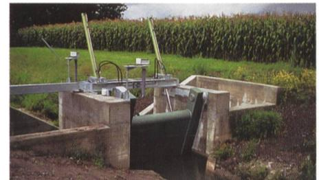
Bild 4. Beispiel Rückhaltevorrichtung.
