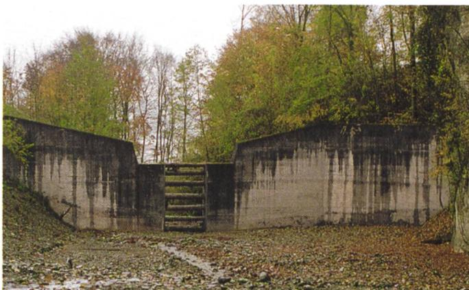
Bild 1. Balkensperre als Abschlussbauwerk des Geschiebesammlers am Sigetsbach in Sachseln OW.
