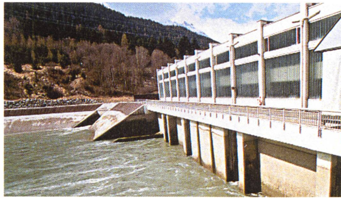
Bild 10. Abdichtung einer eingestauten Aussenwand einer Kraftwerkzentrale.
