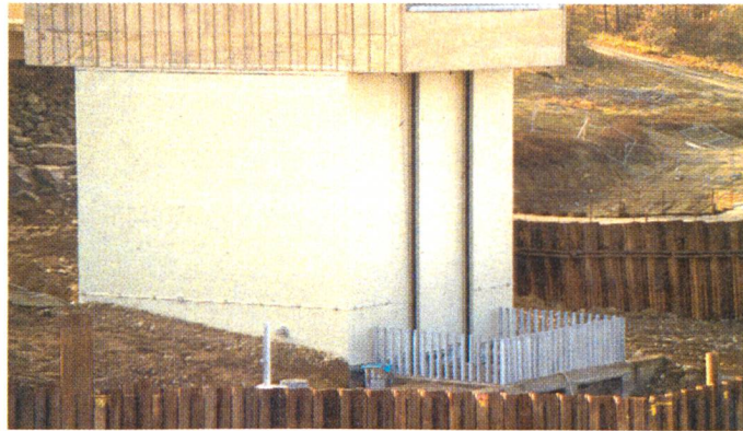
Bild 11. Entnahmeturm Bautzen, Deutschland: Turm beschichtet, Nord- und Ostfassade.
