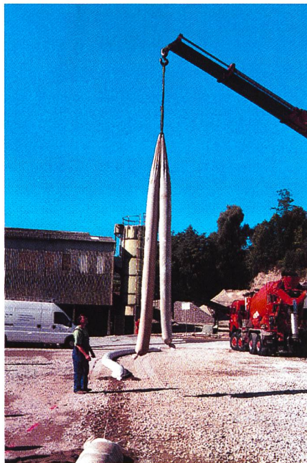
Bild 1. Verlegung von Quick-Snake.
