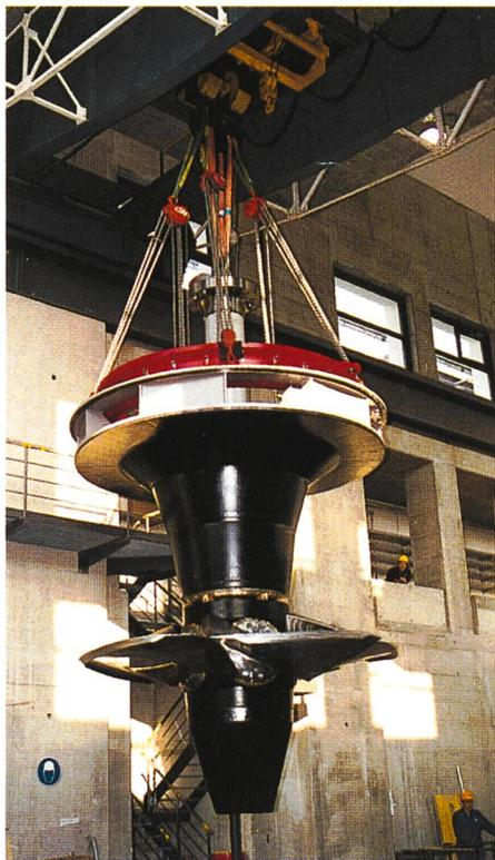
**Bild B7-1. Einfahren und Montage der Turbine Gruppe 3. Die mit dem Maschinensaalkran versetzte Turbine mit einem Lauftraddurchmesser von 3,60 m und fünf Schaufeln ist mit dem Turbinendeckel und der Turbinenwelle 34 Tonnen schwer.**
