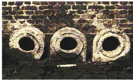
Bild 1. Drei Rohrsteine der römischen Wasserleitung von Bonn.
